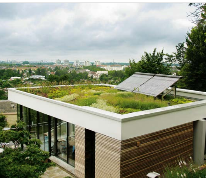
Sinnvolle Kombination: Gründach und Solar-Anlage
