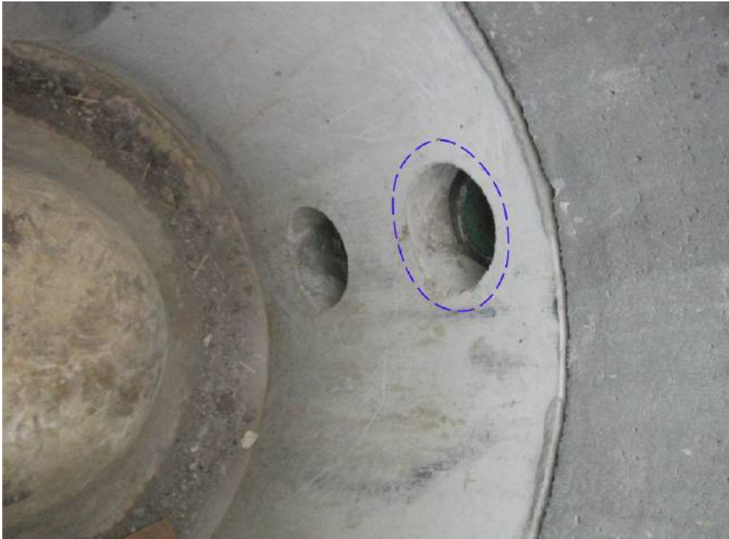
Abb. 11: Aufweitung aus 2015 (gestrichelt), dies ist jetzt auch mit der unteren Drossel vorzunehmen
