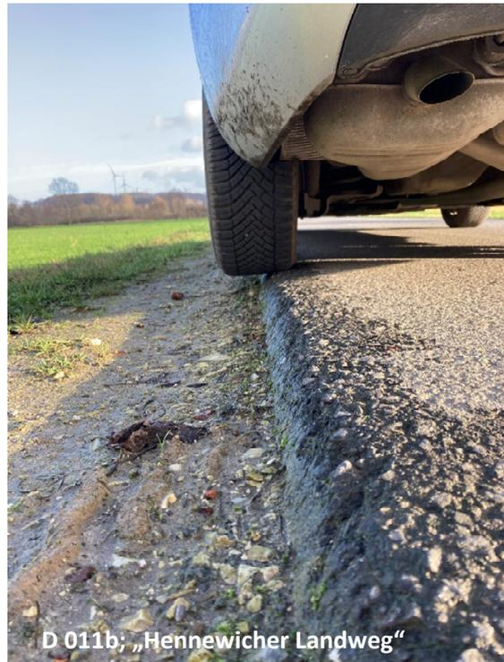
**Foto 11: Höhenunterschied zw. Asphaltkante und Seitenbereich**
