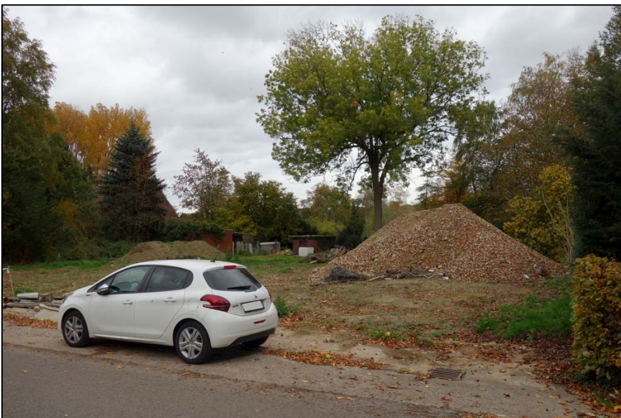
Abb. 2: Plangebiet / Vorhabengrundstück nach Gebäudeabbruch. Blick aus westlicher Richtung.
