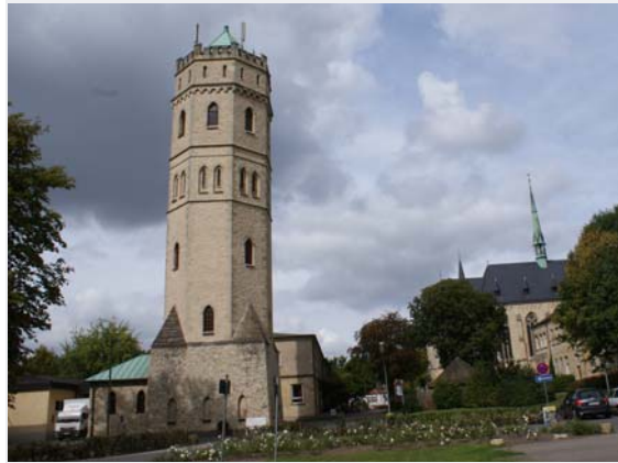
Alter Wasserturm Stift Tilbeck | bs
